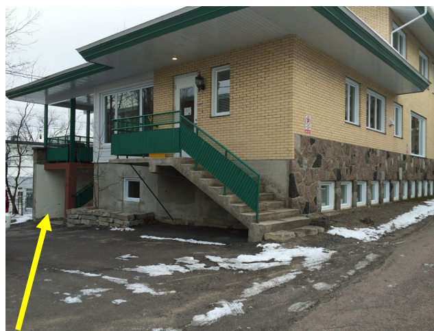
L'accès à l'arrière du bâtiment
