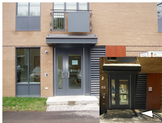
L'accès à l'arrière du bâtiment Maintenant avec rampe d'accès
